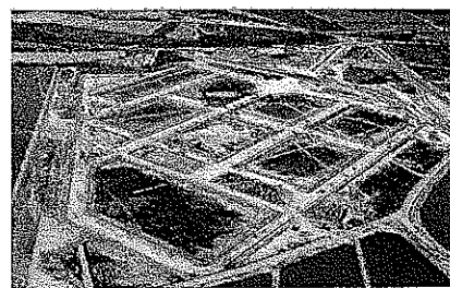
Urbanización Polígono Industrial en Pulpí
